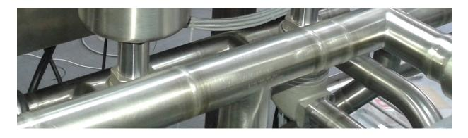
Pic.7 夹套循环管道 jacket circulation pipelines
