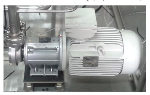
Pic.8 格兰富磁力泵 Grundfos magnetic pump
